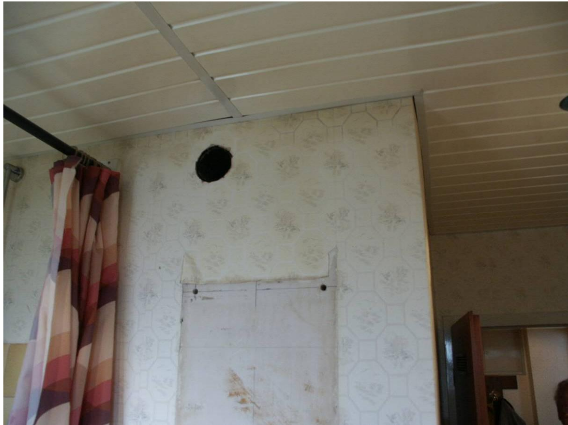
Nach Demontage der alten Heizungsanlage
